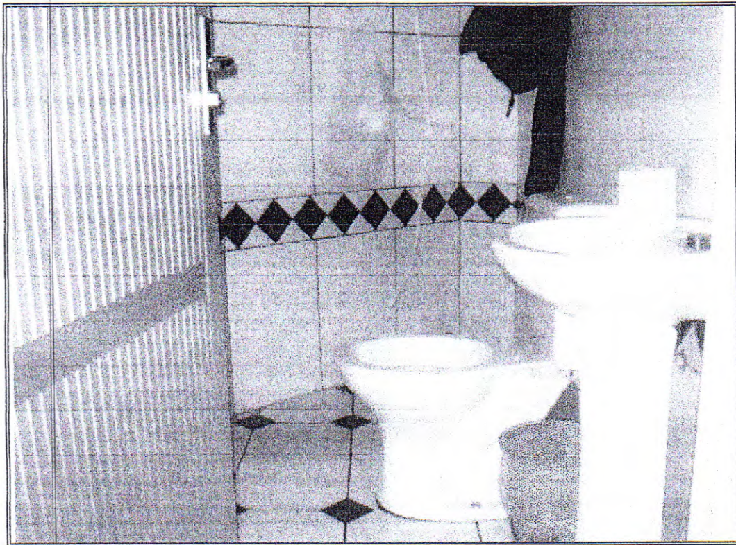
VISTA DO SANITÁRIO SITUADO NO PRIMEIRO PAVIMENTO
