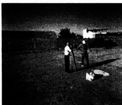
11 – Demarcação locação tubulões Data 03 a 30 /08/2011
