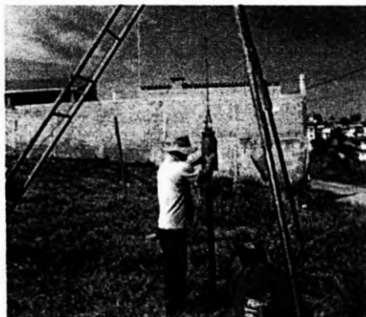
5 –Sondagem estudo da resistência do solo. Data 26/09/07
