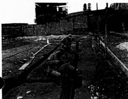
17 - Colocação ferragens nas caixas Data 15/10 a 30/10 /2011
