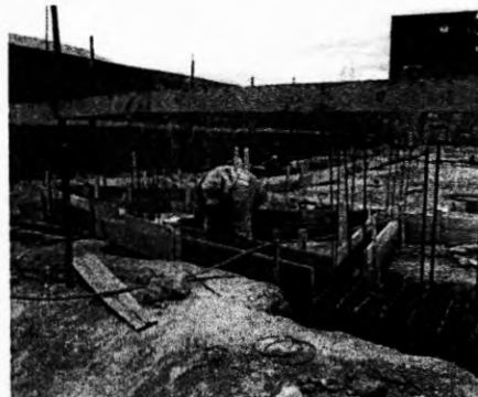
18 - Montagem formas cintamento Data 25/10 a 05 /11/2011
