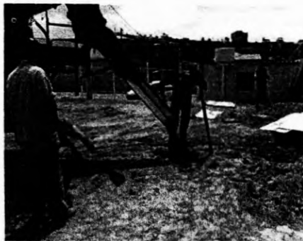
14 - Enchimento dos tubulões (CONCRETOMIX). Data 20-22 /09/2011
