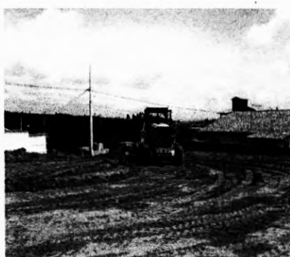
8 - Serviço de terraplanagem 10 e 12/08/ 2008
