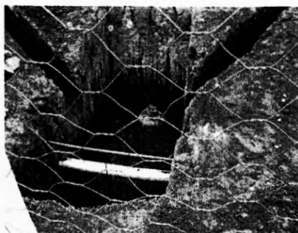
15 - Abertura das caixas Data 23 /09 a 15/10 /2011
