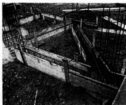
20 -Cintamento da base. Data 08 a 15 /11/2011
