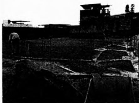
21 - Preparação da base Data 16 / 11 a 03/12/2011
