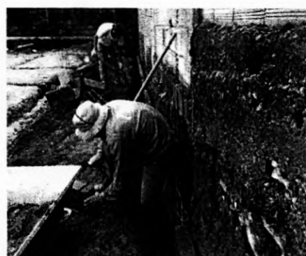
23 - Fundação muro de arrimo Data 16 / 11 a 03/12/2011
