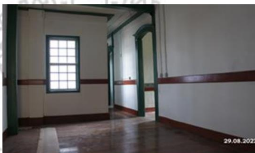
Foto:06 Obra de restauro salão de recepção Data: 29/08/22 Fotógrafo: Mauro Dutra
