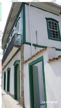
Foto: 08 Fachada do imóvel Data: 12/09/22 Foto : Mauro Dutra
