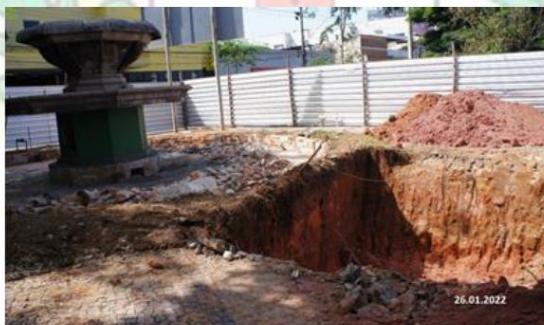
Foto: 03 - Obra de restauro Data: 26/01/22 Fotógrafo: Mauro Dutra
