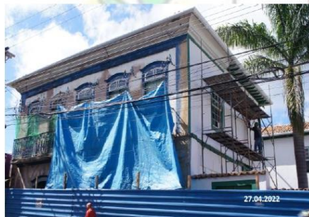
Foto:03 Obra de restauro fachada Data: 27/04/22 Fotógrafo: Mauro Dutra
