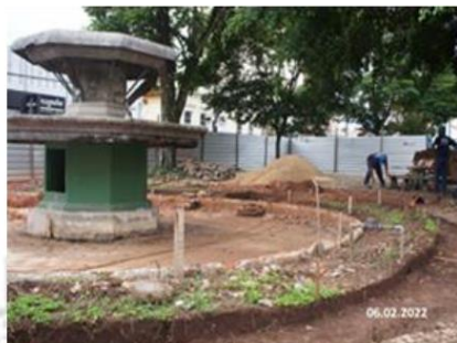
Foto: 05 Obra de restauro Data: 06/02/22 Fotógrafo: Mauro Dutra
