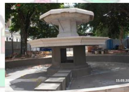
Foto: 07 Obra de restauro Data: 15/03/22 Fotógrafo: Mauro Dutra
