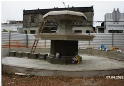
Foto: 09 - Instalação hidráulica e elétrica Data: 07/04/22 Foto : Mauro Dutra
