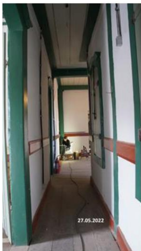
Foto:05 Obra de restauro corredor Data: 27/05/22 Fotógrafo: Mauro Dutra
