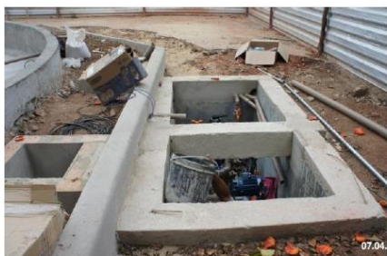
Foto: 08 - Instalação hidráulica e elétrica Data: 07/04/22 Fotógrafo: Mauro Dutra
