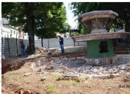
Foto: 02 - Início da obra de restauro Data: 26/01/22 Fotógrafo: Mauro Dutra
