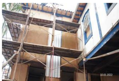
Foto: 01 - Vista externa da Obra Data: 10/01/22 Fotógrafo: Mauro Dutra
