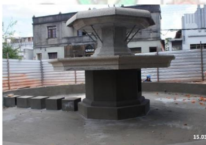
Foto: 06 Obra de restauro Data: 15/03/22 Fotógrafo: Mauro Dutra
