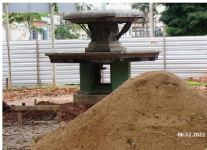
Foto:04 Obra de restauro Data: 06/02/22 Fotógrafo: Mauro Dutra
