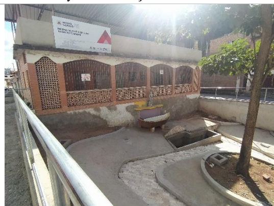
Figura 10: Vista parcial da Fonte, em processo de reforma Autoria: Tayami F. França - Data: 28/04/2022
