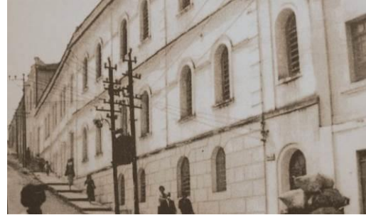
Figura 06: Vista em detalhe da platibanda Foto: Acervo do Colégio de Nossa Senhora de Nazaré – Data: 1958
