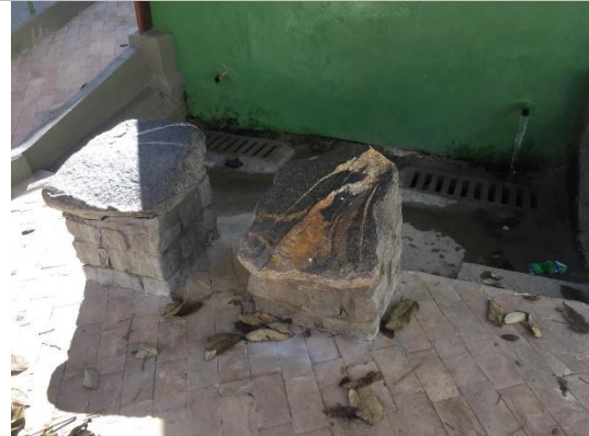
Figura 06: Detalhe das pedras e bicas Autoria: Mauro Dutra de Faria – Data: 06/07/2022
