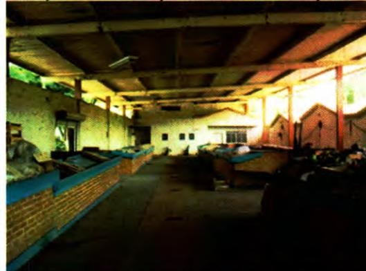
Rampa de entrada da praça de alimentação fiação exposta, trinca na parede, reboco caindo e fiação exposta.
