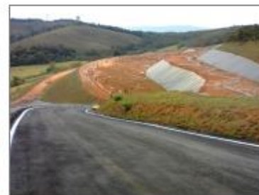
Visão Bacia Norte antes da operação
