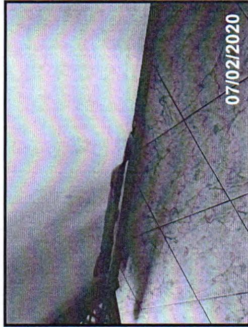
Queda de reboco das paredes
