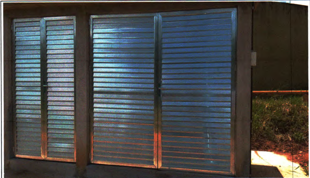
Foto 5: Quadro de Comando dos Sopradores e Exaltadores.
