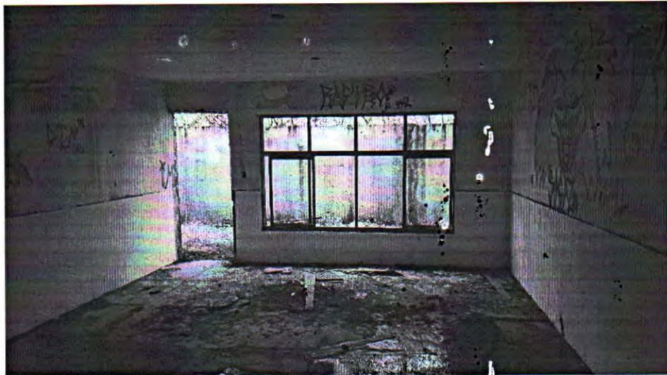
Figura 29 - Infiltrações e má conservação do ambiente. Fonte: Acervo técnico
