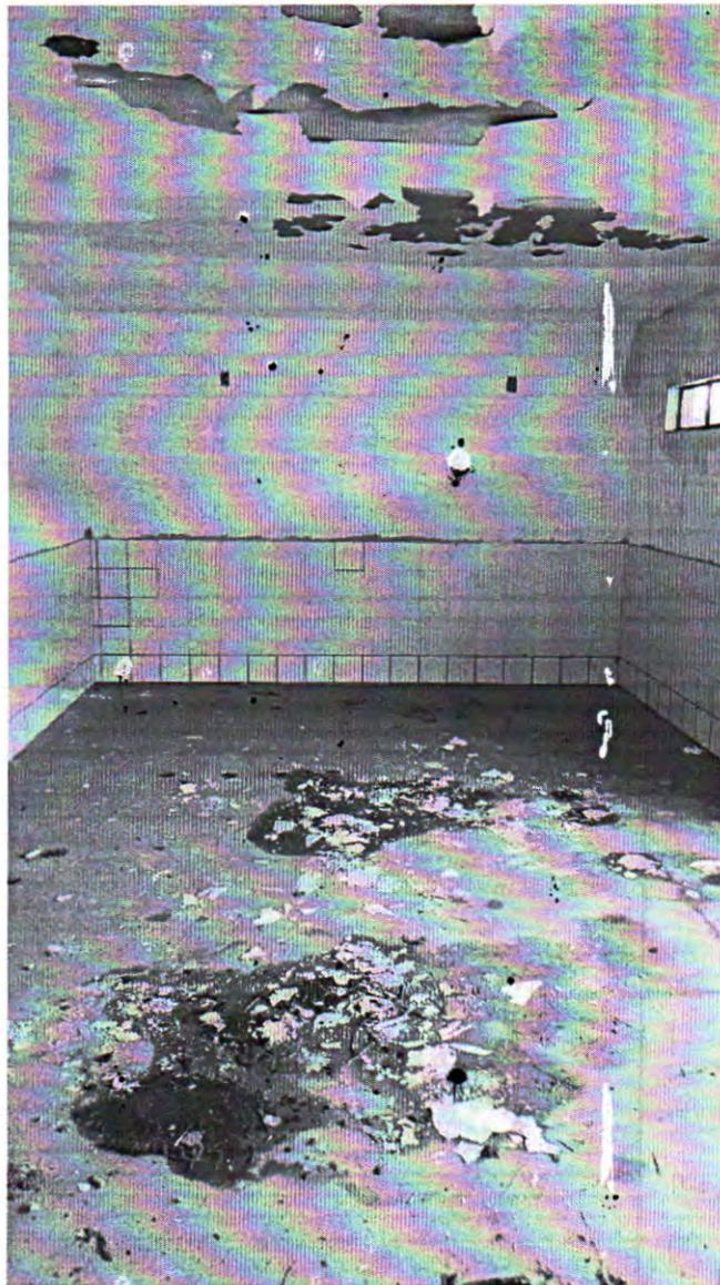
Figura 24 - Infiltrações e má conservação do ambiente. Fonte: Acervo técnico
