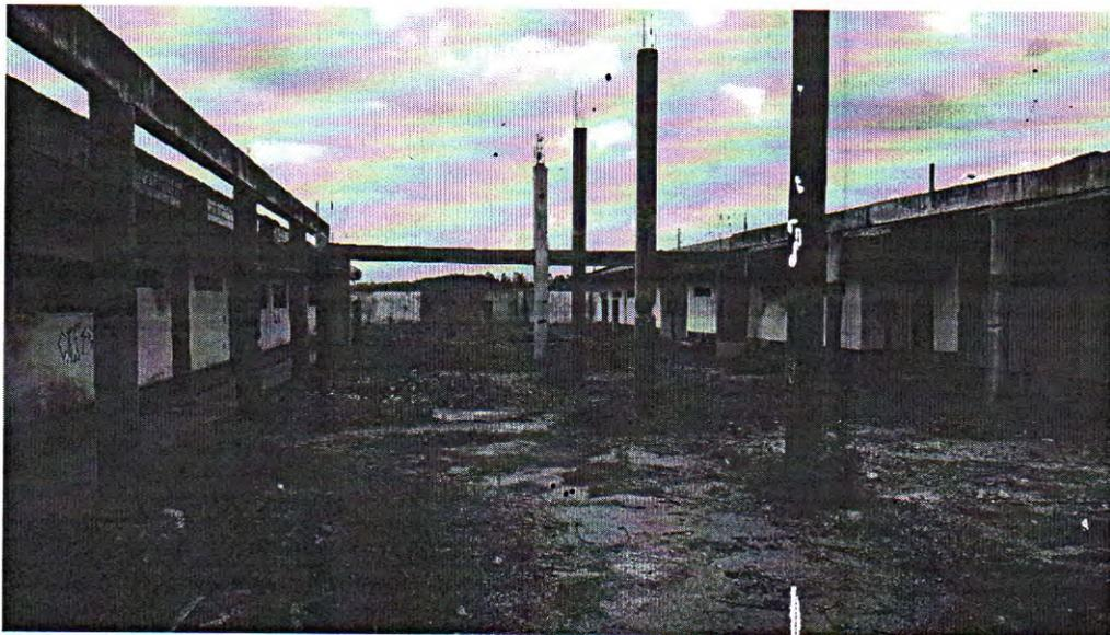
Figura 8 - Pilares inacabados e com armadura exposta no pátio. Fonte: Acervo técnico
