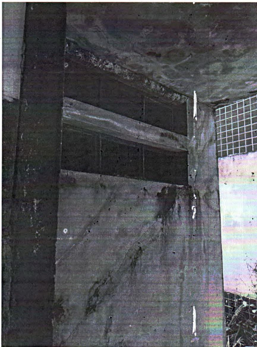
Figura 35 - Trincas provenientes da ausência de vergas e contra-vergas, perfil metálico corroído e indícios de infiltração na laje de cobertura. Fonte: Acervo Técnico
