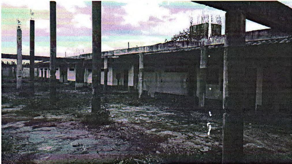
Figura 9 – Pilares inacabados e com armadura exposta no pátio. Fonte: Acervo Técnico.
