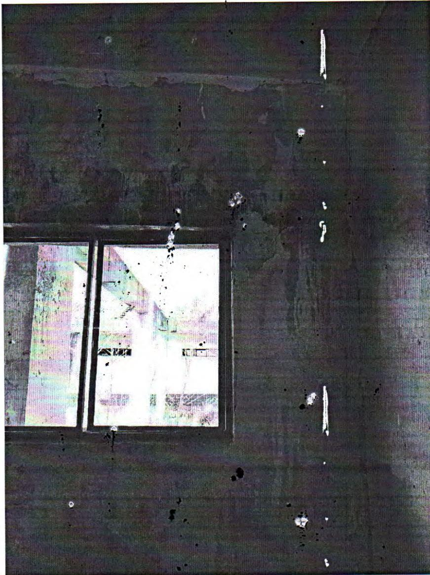
Figura 34 - Trincas provenientes da ausência de vergás e contra-vergas
