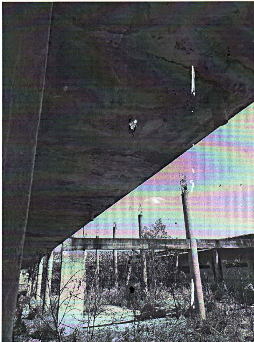
Figura 18 - Beirais apresentando patologias decorrentes de infiltrações. Fonte: Acervo Técnico.
