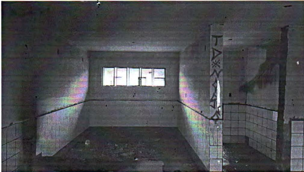
Figura 27 - Infiltrações e má conservação do ambiente. Fonte: Acervo técnico
