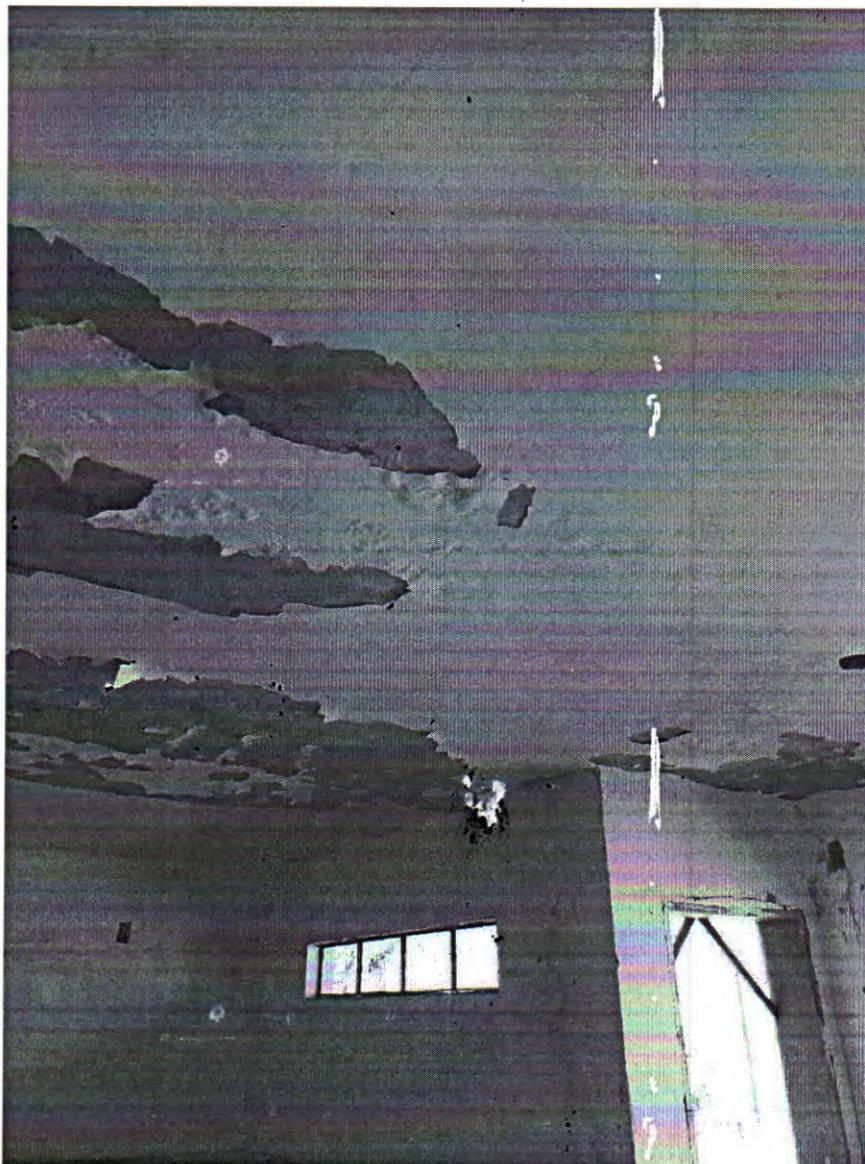
Figura 23 - Indícios de infiltração na laje. Fonte: Acervo Técnico.
