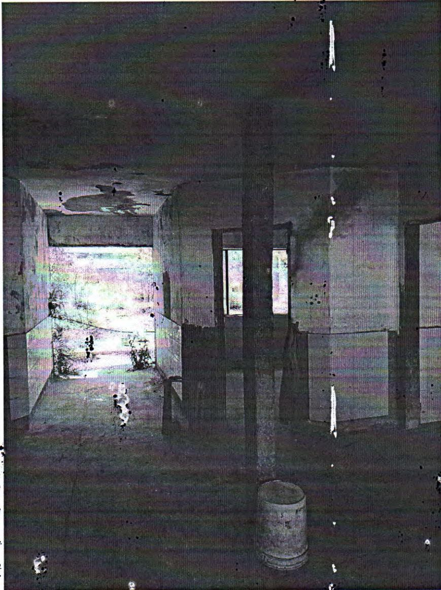
Figura 31 - Pilar executado em desconformidade com o projeto
