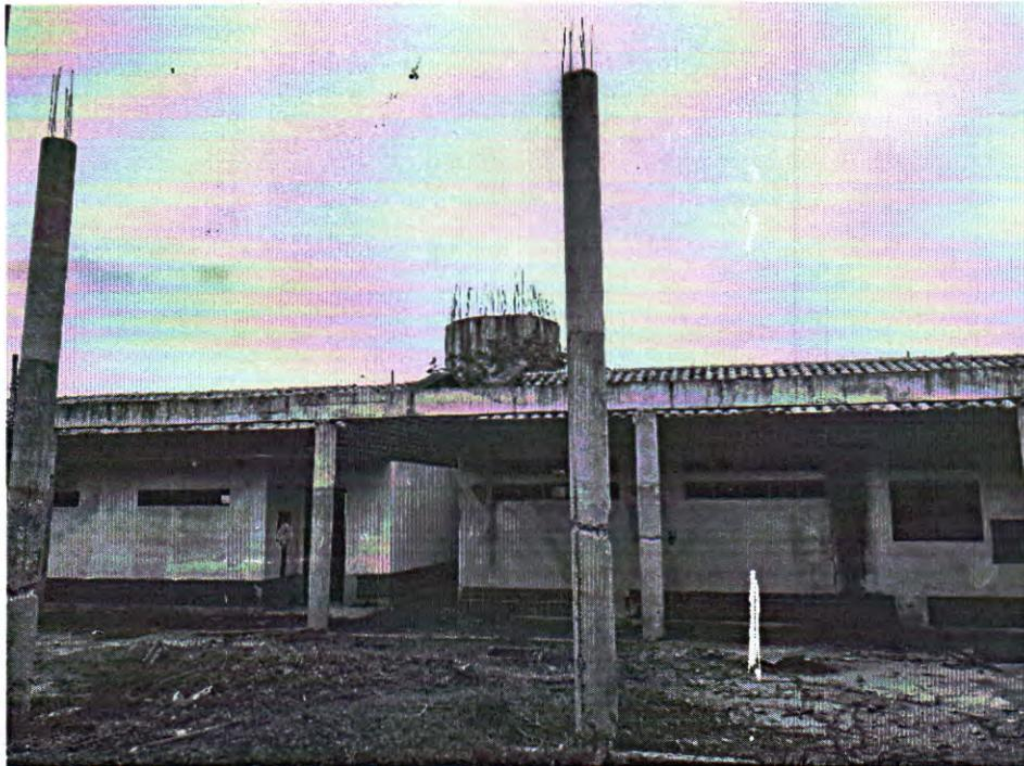
Figura 2 - Castelo d'água - armaduras expostas no topo. Fonte: Acervo técnico
