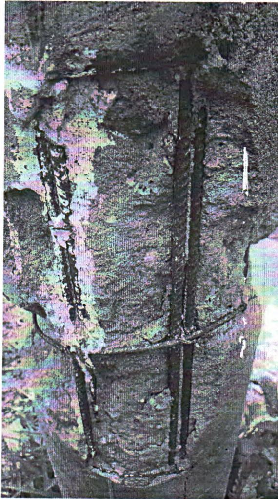
Figura 5 - Armadura exposta nos pilares do pátio. Fonte: Acervo técnico
