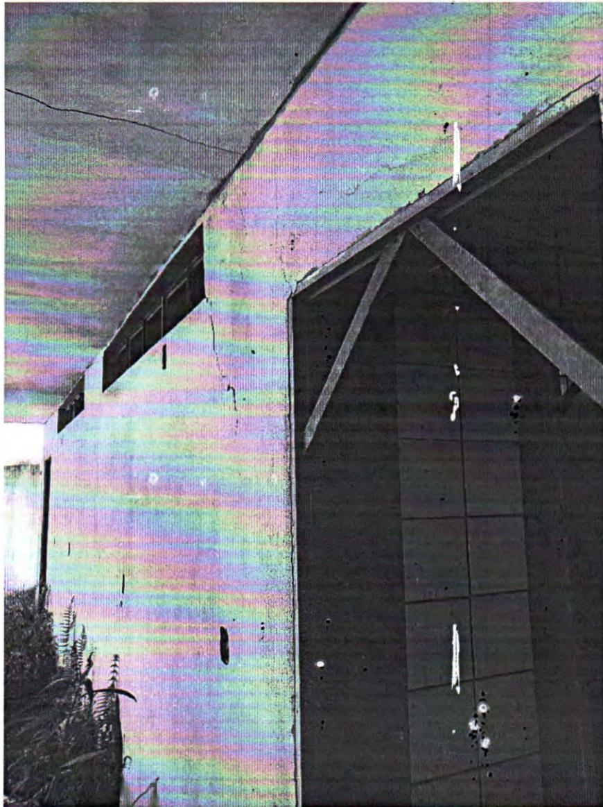
Figura 33 - Presença de fissuras devido à ausência de vergas e contra-vergas
