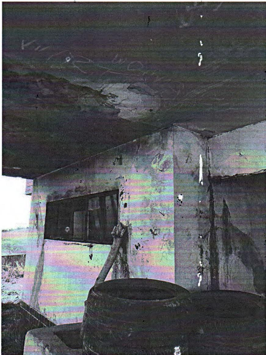
Figura 25 -Indícios de infiltração na laje de cobertura. Fonte: Acervo Técnico.
