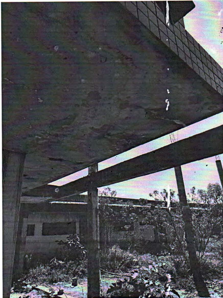
Figura 17 - Beiral executado em desconformidade com o projeto. Fonte: Acervo Técnico.
