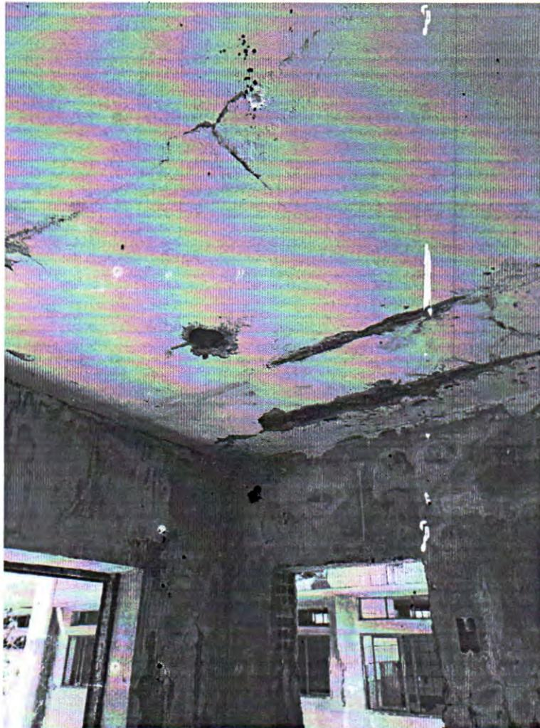
Figura 28 - Infiltração na laje de cobertura. Fonte: Acervo Técnico.
