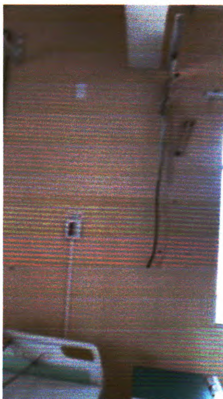
Paredes com canos “conduíte” expostos e soltos
