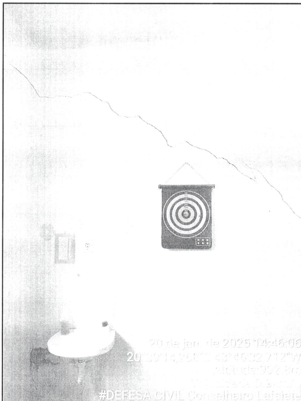
Figura 10 – Trinca na parede entre a sala de enfermagem e a lavanderia.
