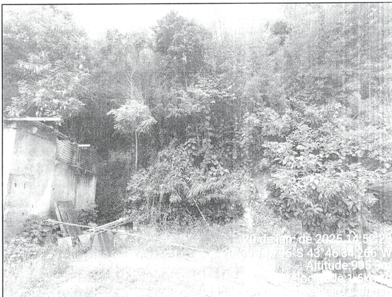
Figura 13 – Talude ao fundo da edificação.
