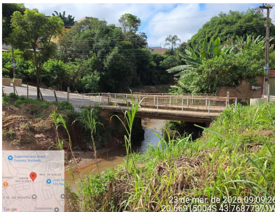
Foto 1: Vista da ponte Fonte: Autor (2026).
